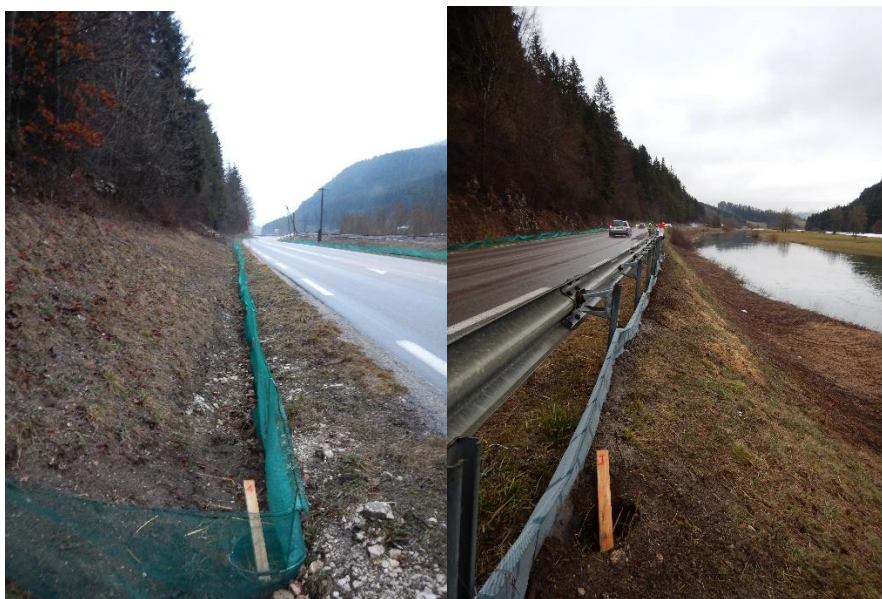
Figure 2 : Dispositif barrière-piège installé côté site d'hivernage (photographie de gauche avec les filets DIATEX) et côté site de reproduction (photo de droite avec les filets SODILOR) © LPO FC, 2019.
