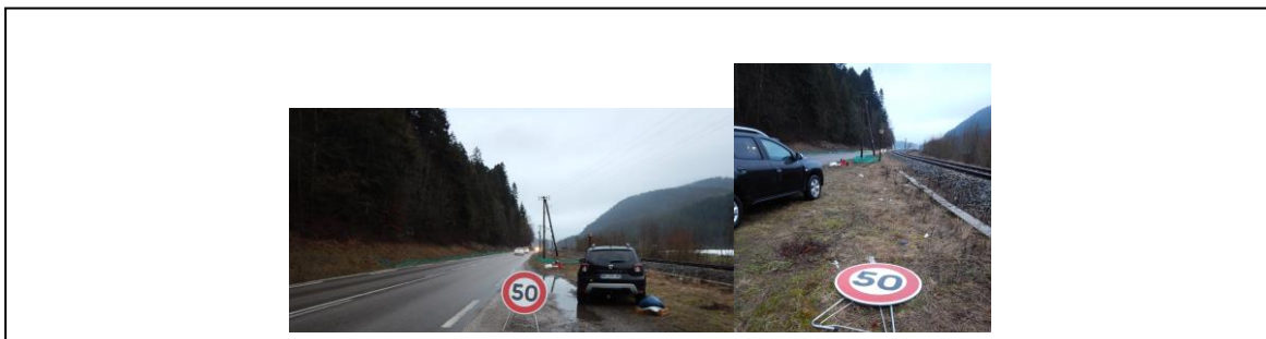
Mise en place des panneaux de signalisation 50 km/h en bas et en haut du dispositif
