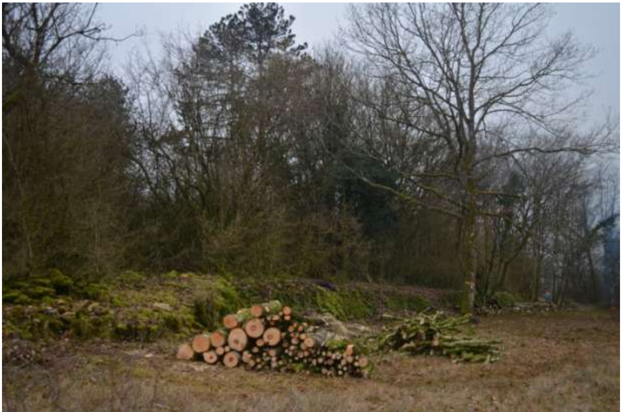
Vue du long mur le 8 février 2018, juste après sa remise en lumière (cliché Christian Chirio)
