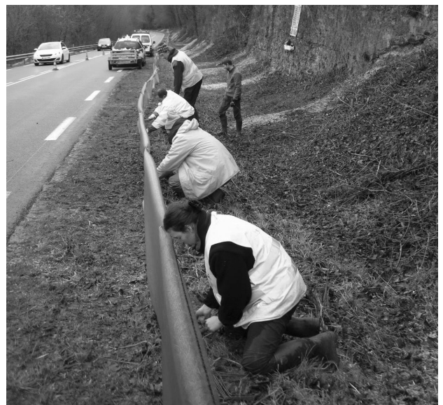
Installation du dispositif de protection des amphibiens © Georges Lignier
