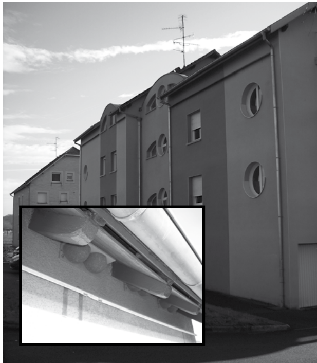
Pose de nids artificiels à Argiésans et Grandvillars (90)
