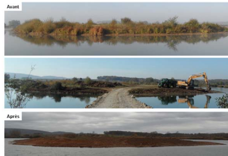
Travaux de reprofilage de l'île à Pagney © Cyrielle Bannwarth
