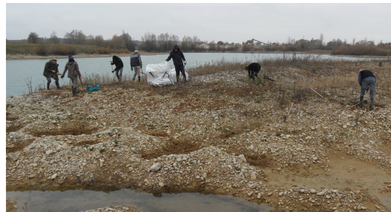
Chantier participatif © Cyrielle Bannwarth
