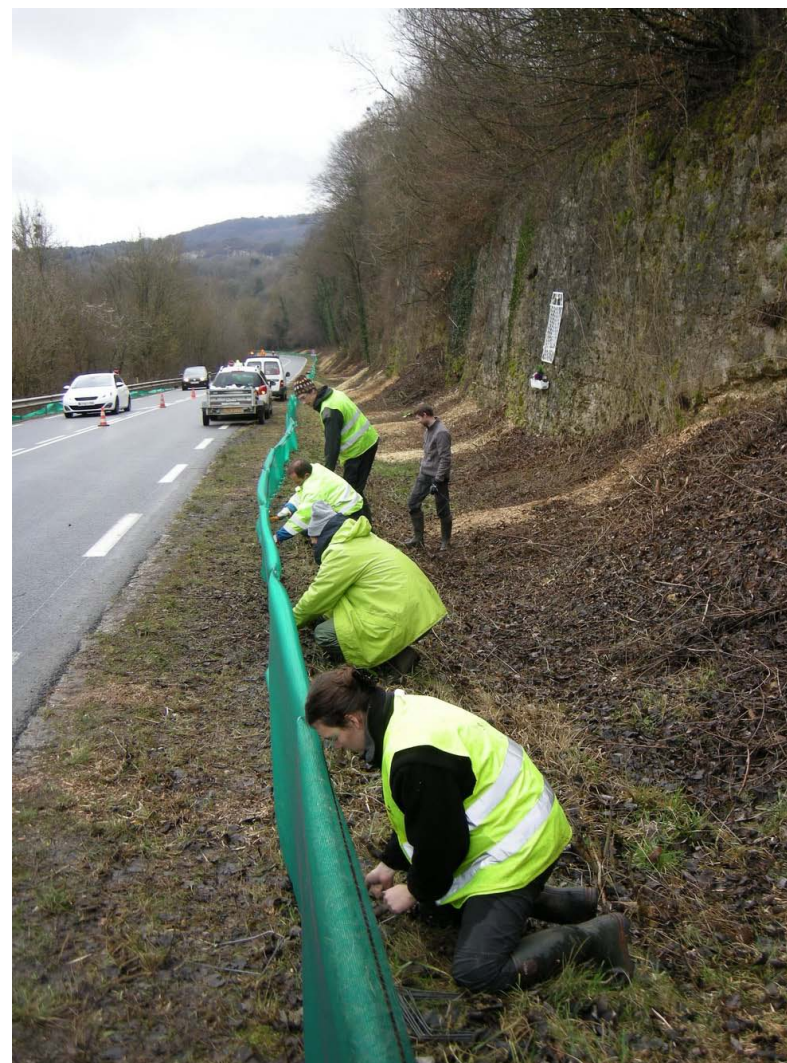
Installation du dispositif de protection des amphibiens © Georges Lignier
