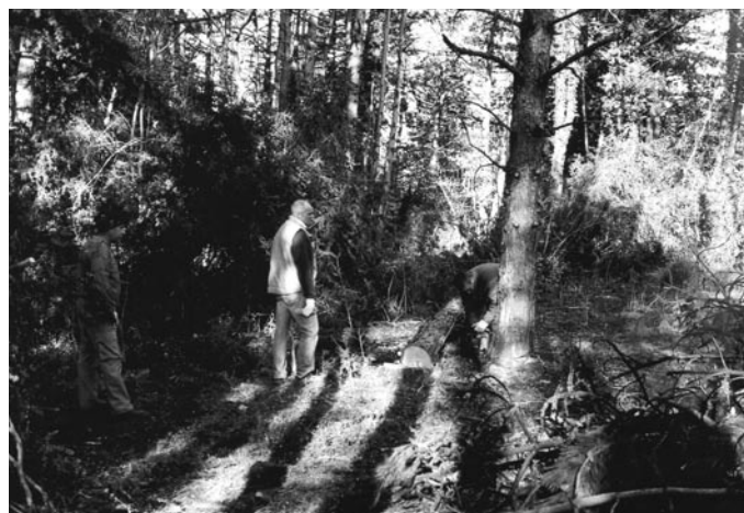
Chantier communal du corridor écologique © Hugues Pinston
