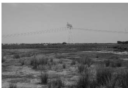
Vue de la zone depuis la route Photo : L. Couzi
