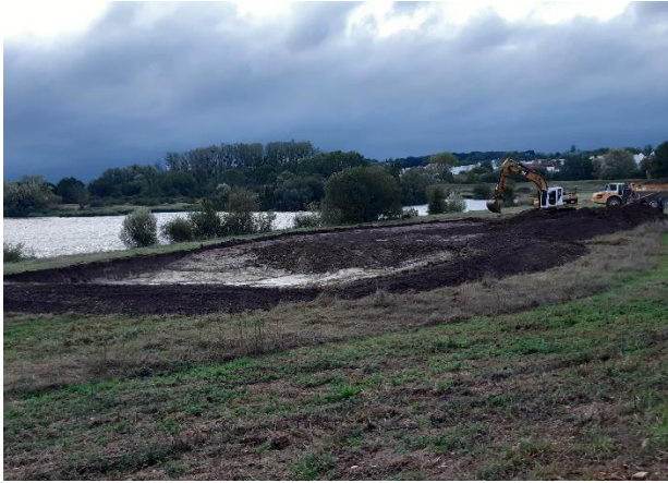
Remodelage des berges sud-ouest
