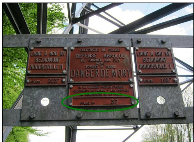
Numéro de pylône dans le cercle vert.
