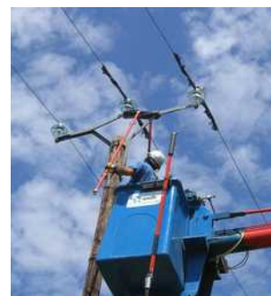
Sécurisation d'un poteau dangereux, par les équipes d'ERDF.
