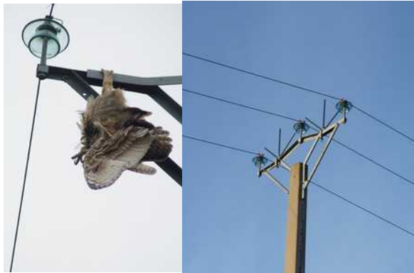
Grand-duc électrocuté sur un poteau (qui a été sécurisé par la suite).
