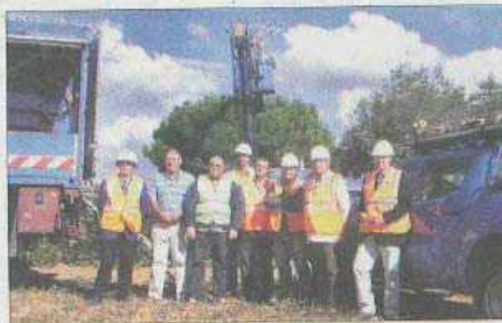
Les élus de Saint-Hippolyte et l'équipe d'ERDF présents sur le site, pour procéder à l'installation de protections pour les oiseaux.
