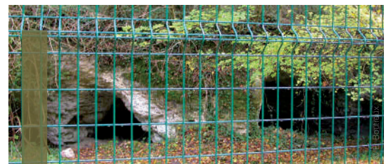
Grillage aux abords d'une cavité
