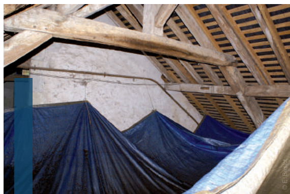
Bâches de protection dans un comble
