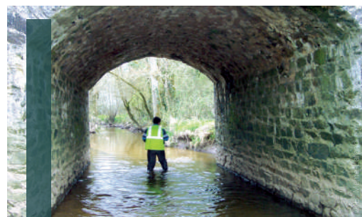
Expertise d'un pont
