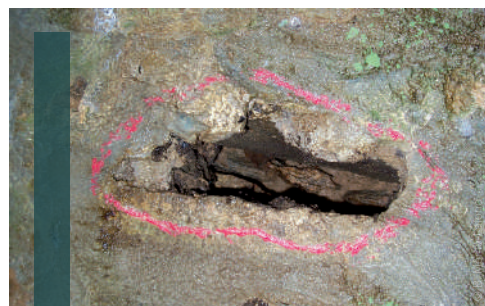
Marquage des disjointements pour maintien
