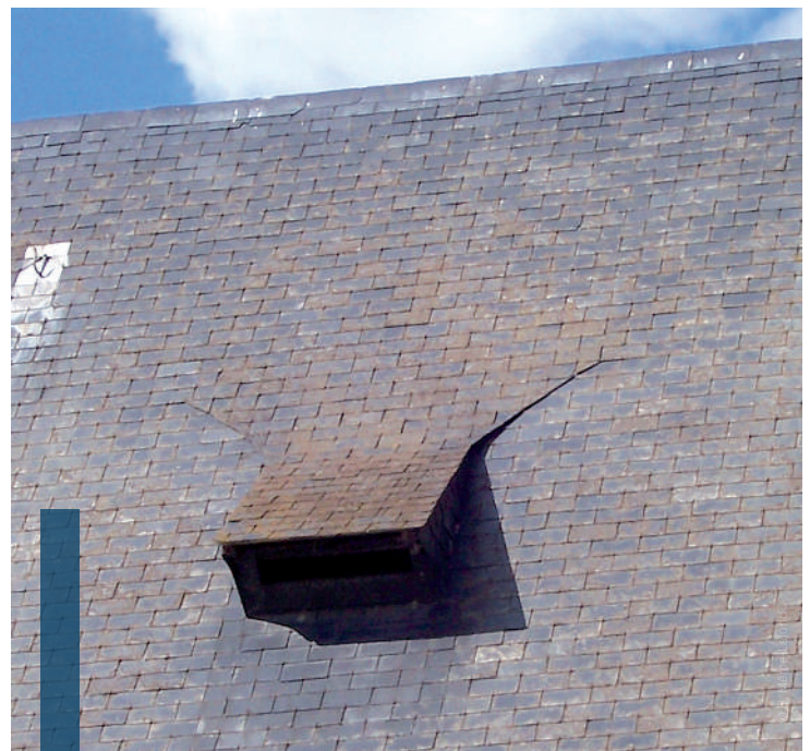
Chiroptière sur le toit d'une église
