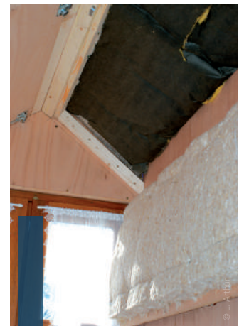
Construction d'un caisson isolé
