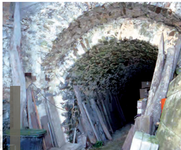
Entrée d'une cave abritant des chauves-souris en hiver
