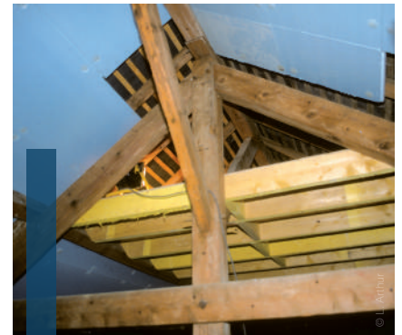
Installation d'un plancher
