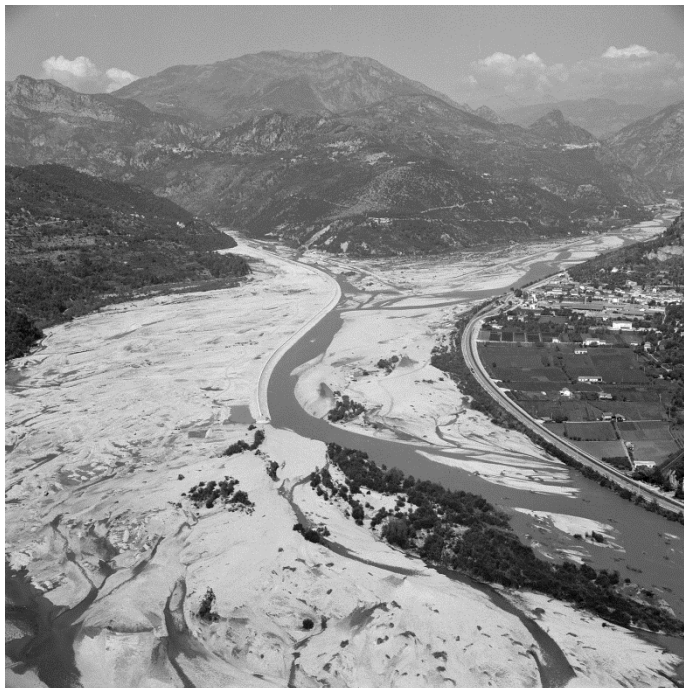
Bec de l'Estéron vue sud/nord en 1965. Construction de la digue rive droite qui laissera place au lac du Broc et à la zone industrielle de Carros © Archives départementales des Alpes-Maritimes
