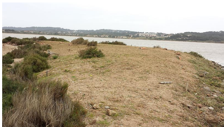
Chantier réalisé sur l'îlot à flamants en avril 2014 : avant et après (A.Audevard)
