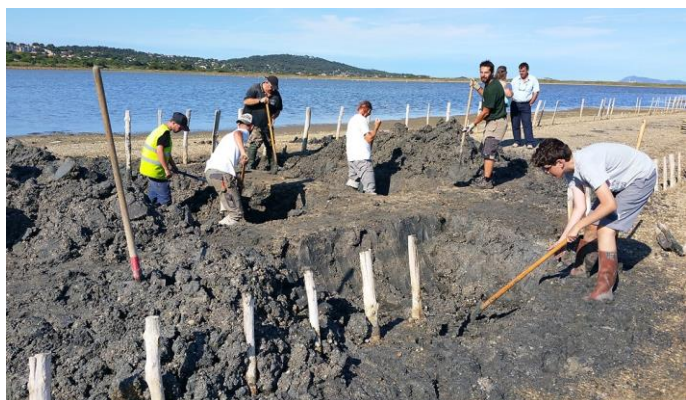
Création d'un emprunt en périphérie de l'îlot à flamants en juillet 2015 - (A.Audevard)
