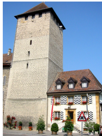
Abbildung 3-1; Grosser Turm des Schloss Murten. Unter dem Dach befinden sich die Nistkästen für die Dohlen.
