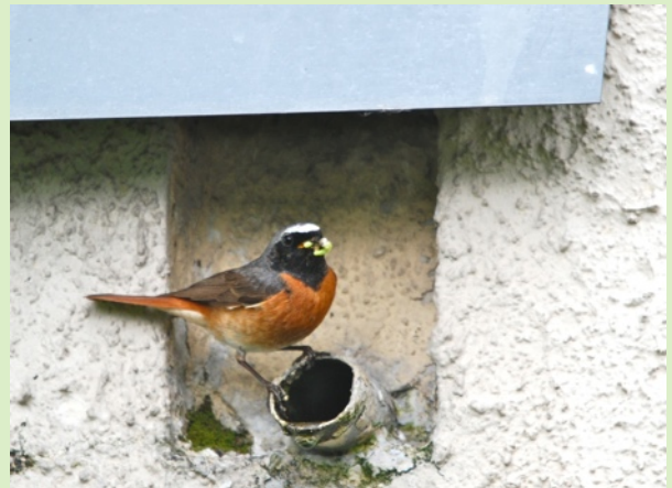
tuyau de récupération sous un toit (Lancy)
