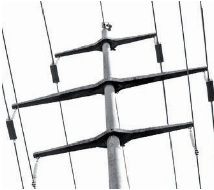
Pylône électrique assaini à Broc Photo : Adrian Aebischer
